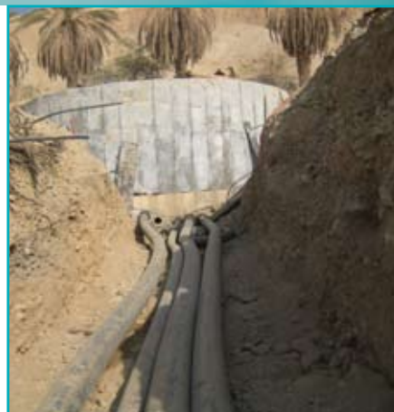
נחל ערוגות "פקסגול" 280 מ"מ כחלק משיפור מערך אספקת המים לקיבוץ עין גדי
